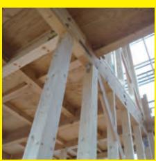
家を支える柱と梁。もっとも大切な構造躯体は、集成材を使用しています。木が持つ本来の特性を考えて適材適所に樹種を選び、しっかりと頑強で強固な構造躯体を作り上げています。
