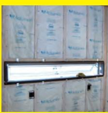
永く快適に暮らしていくために、高気密高断熱施工を行っています。また、壁には透湿防水シートを施工し、さらに省エネで快適な住まいとなっています。
