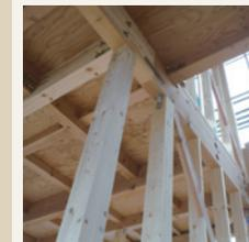
家を支える柱と梁。もっとも大切な構造躯体は、集成材を使用しています。木が持つ本来の特性を考慮して適材適所に樹種を選び、しっかりとした頑強で強固な構造躯体を作り上げています。
